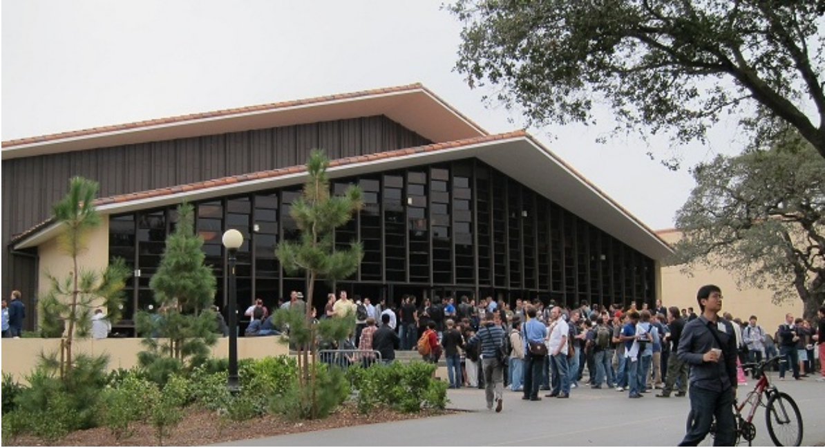
Figure 4.1: Dinkelspiel Auditorium: Outside View.
