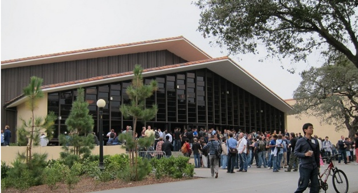
Figure 4.1: Dinkelspiel Auditorium: Outside View.
